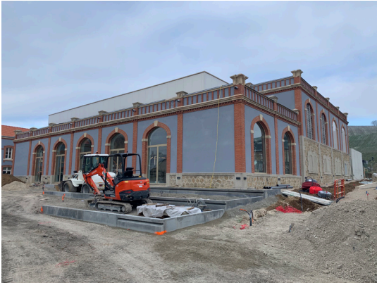
Pressoria en travaux
